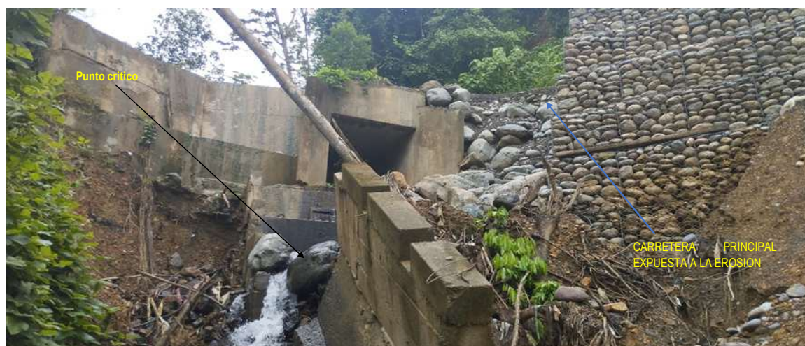
F-02: Tramo crítico en la quebrada Machunchuriato, el cual expone con riesgo de inundación, erosión y hundimiento a la ruta principal: Puerto Asunción-Bellavista, distrito de Anchiuay, Provincia de La Mar - Ayacucho.
